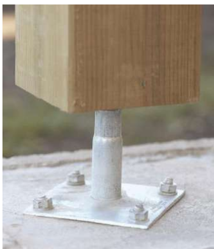
PIEDS DE POTEAU
